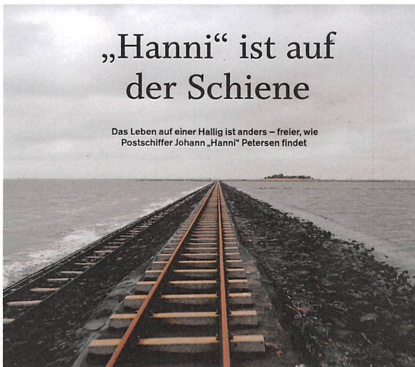
Die Schiene für die Lore wurde höher gelegt, um auch bei hohen Wasserständen fahren zu können.
